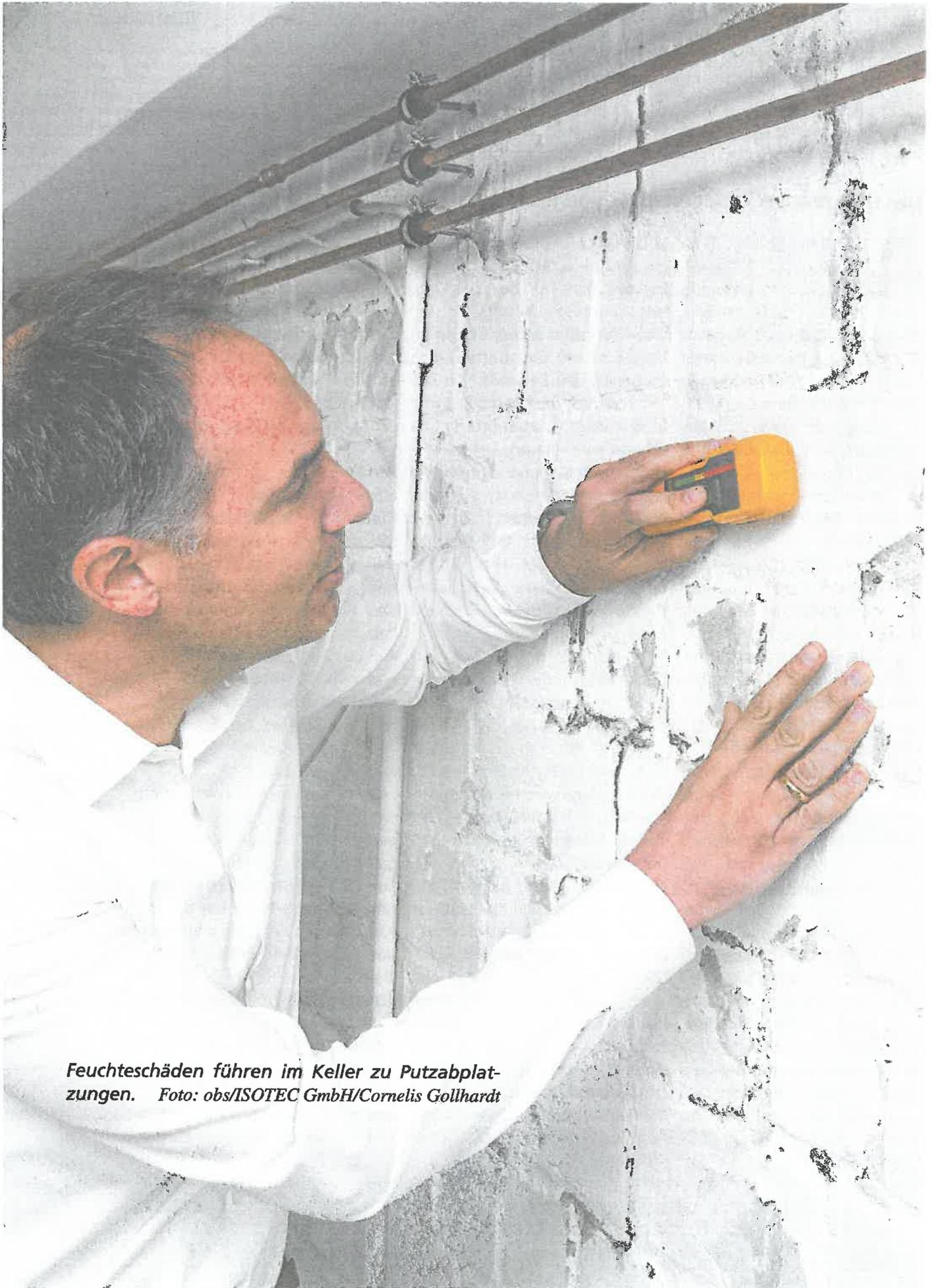
**Feuchteschäden führen im Keller zu Putzabplatzungen.** Foto: obs/ISOTEC GmbH/Cornelis Gollhardt
